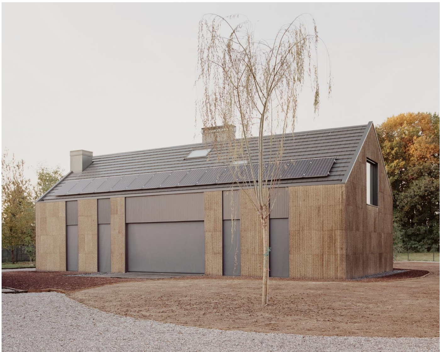
Casa / fronte sud e dettaglio del sughero a vista pantografato in 3D
