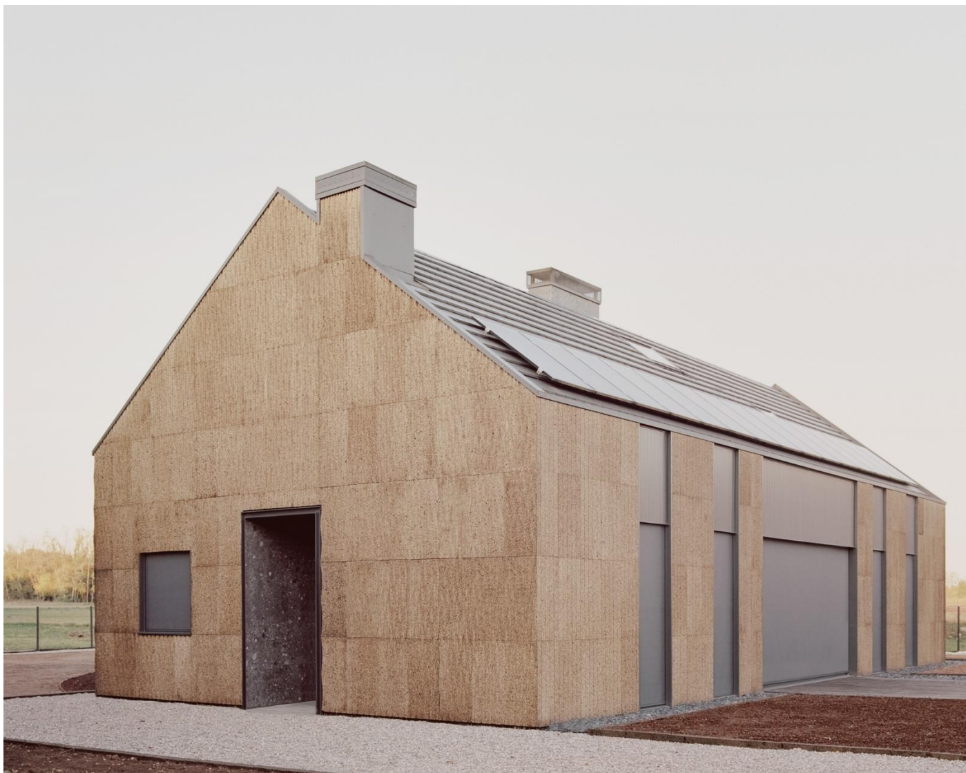
casa 4 / fronte sud-ovest e fronte ovest
